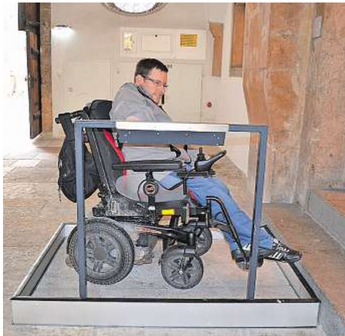
Mit einer Hebebühne, die im Boden versenkbar ist, kommt Frank Reinel barrierefrei in sein denkmalgeschütztes Büro. Foto: Ligeti
